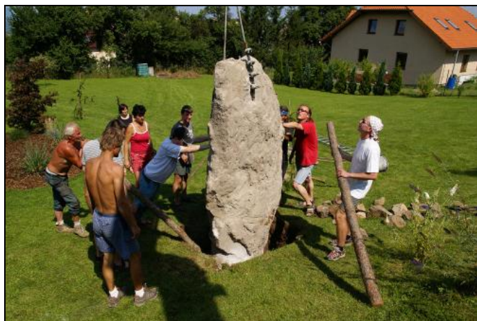
Klíčový okamžik – opatrné spuštění svatebního daru do rychle připravených základů.
